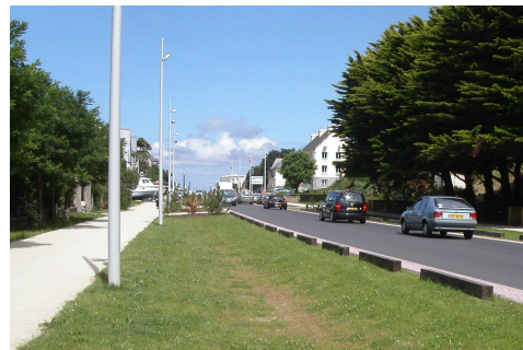
Noues de rétention/infiltration Sables d'Or les Pins (22) Source SAFEGE
