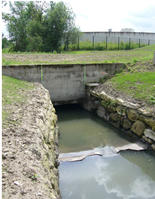
Photo 2-2 : Passage du ru des Grues sous le feeder gaz
