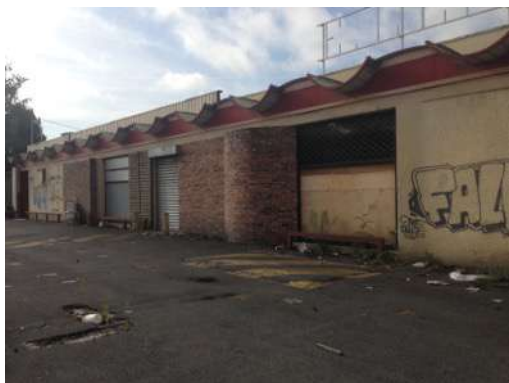
Photos Actipolis : terrain mutable (avenue du Général de Gaulle - proximité place du marché)
