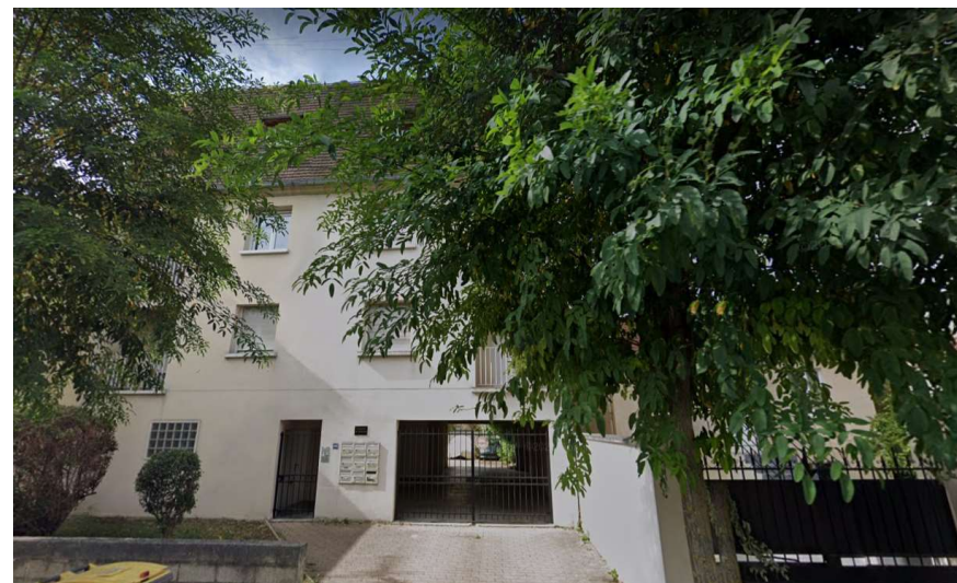
Limite séparative gauche
