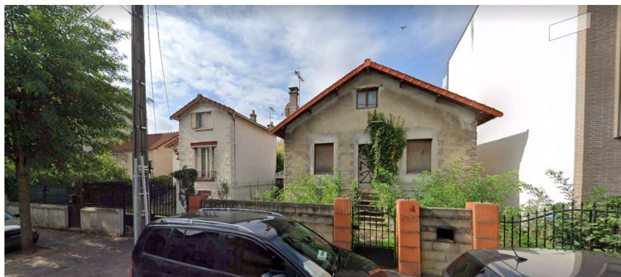
Pavillons à démolir
