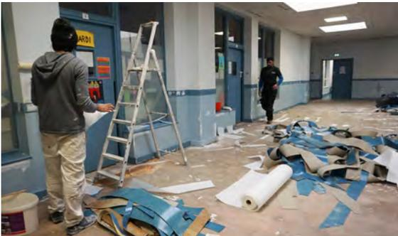
**1.** Dans la salle de motricité de l'école maternelle **Aristide Briand**, réfection de la peinture, des luminaires et remplacement du revêtement de sol (type sol souple). Il s'agit de la première partie d'un chantier qui concernera au printemps les couloirs adjacents, le hall d'entrée et un bureau.
