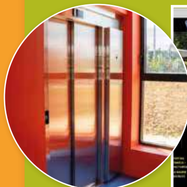
Installation d'un ascenseur à l'école Joliot Curie
